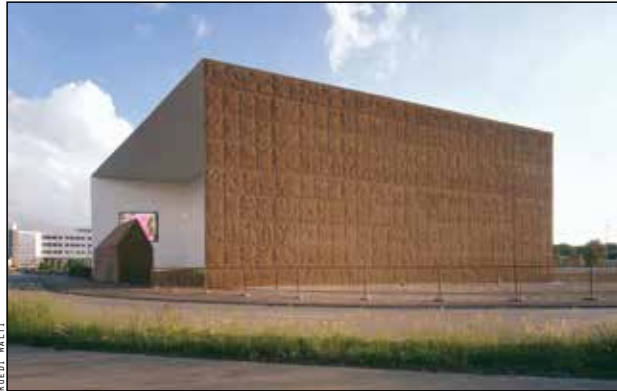
Schaulager® Münchenstein/Basel, Herzog & de Meuron, Architects
